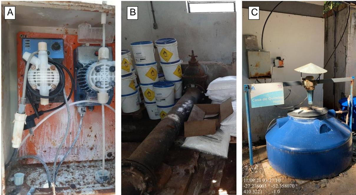
Legenda: (A) Bomba dosadora de Cloro; (B) Acondicionamento de químicos; (C) Misturador de cloro.
